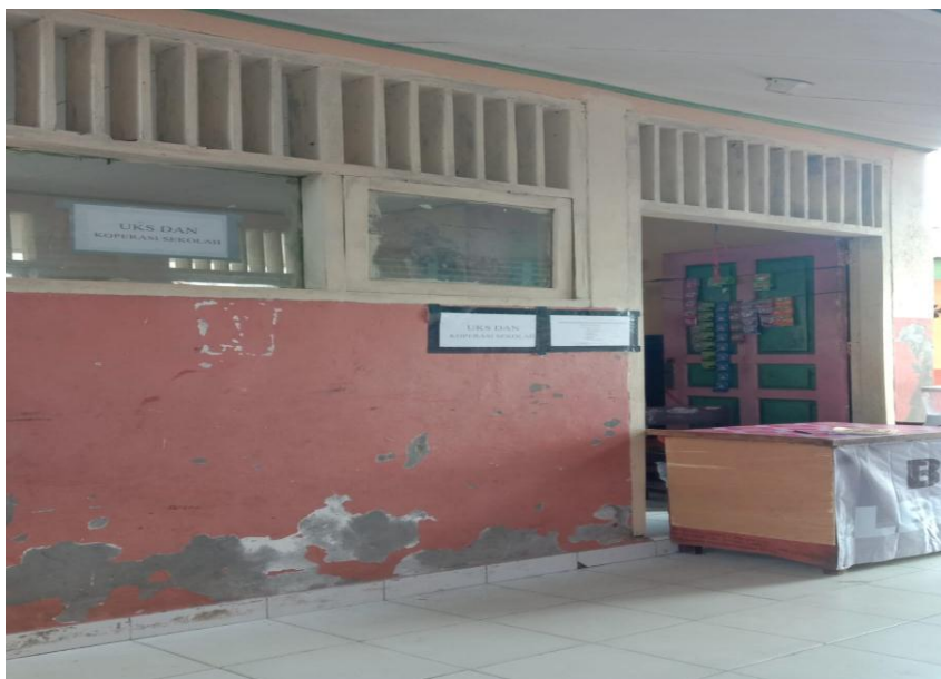
Ruang UKS SDN 50 Kota Bengkulu
