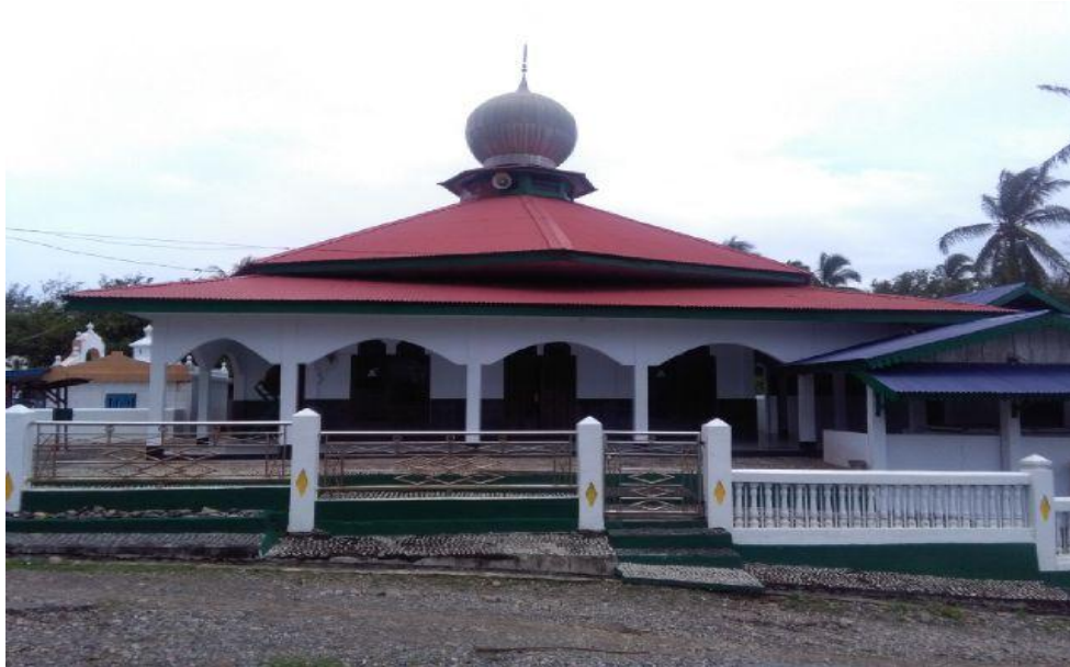
Kondisi Masjid Al-Manar Dari Depan
