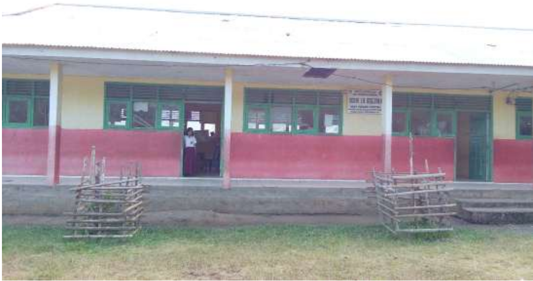
Foto Gedung Sekolah SDN 18 Seluma Desa Padang Genting Kec. Seuma Kab. Seluma
