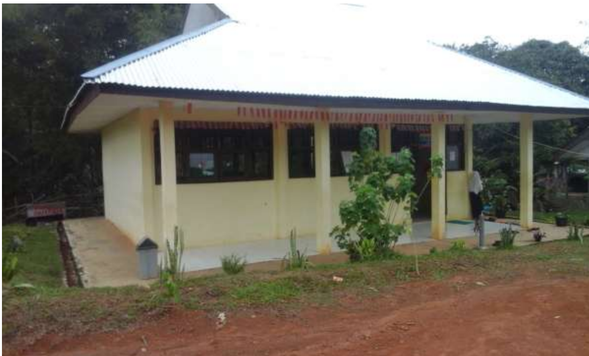
Gambar 6. Kondisi gedung sekolah
