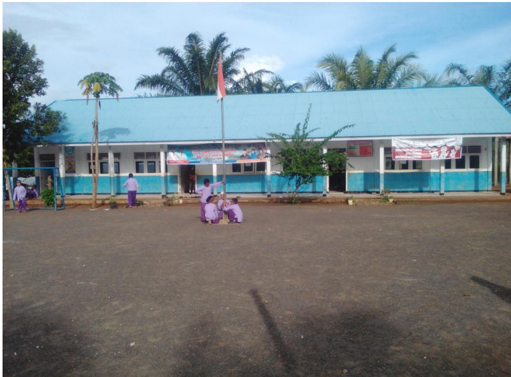
Gambar 8 Ruang Kelas SDN 104 Kota Bengkulu
