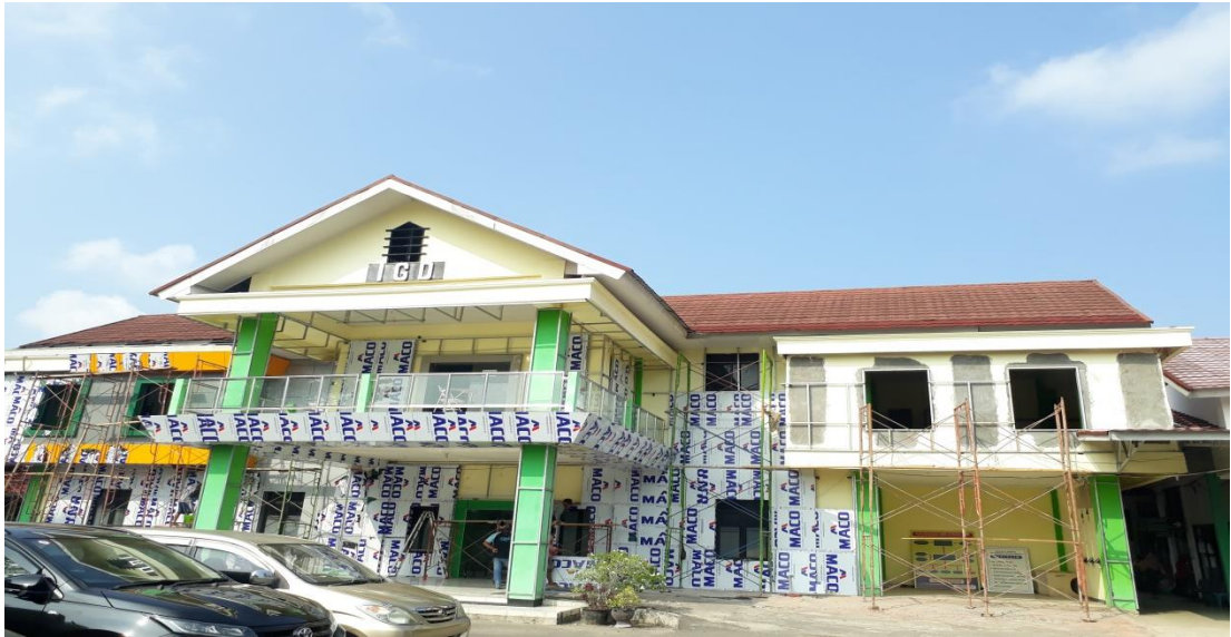
Gedung IGD yang sedang di rehab
