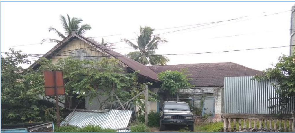
Gambar. 1.2 , Kondisi Fisik Gedung Bagian Luar Sekolah Tsanawiyah di Kabupaten Seluma Saat Ini.
