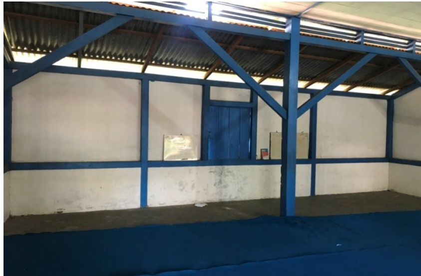
Gambar 3.2 Bagian dinding dalam masjid Al-ikhlas tahun 2020
