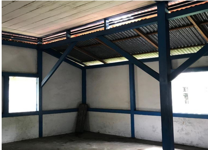
Gambar 3.4 Bagian dinding dalam masjid Al-ikhlas tahun 2020
