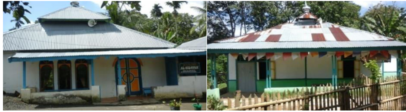
Gambar 3 Kondisi Masjid Desa Talang Pito Dusun I dusun II
