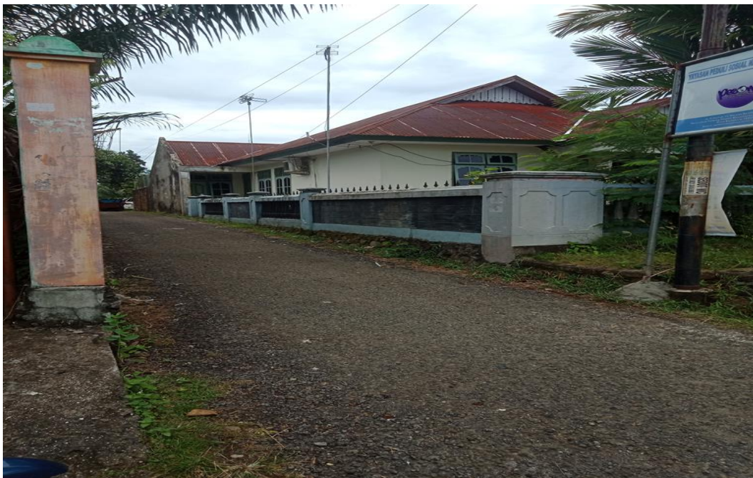
Dokumentasi Jalan Menuju Yayasan Pesona
