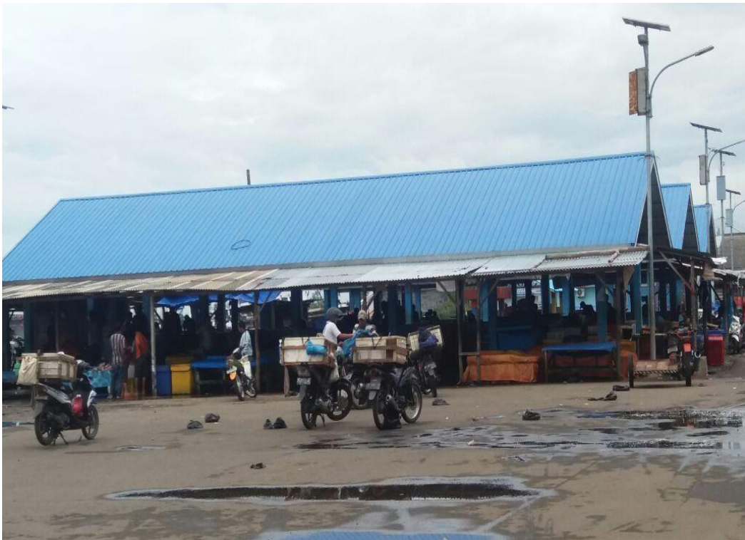
Dokumentasi TPI Pulau Baai
