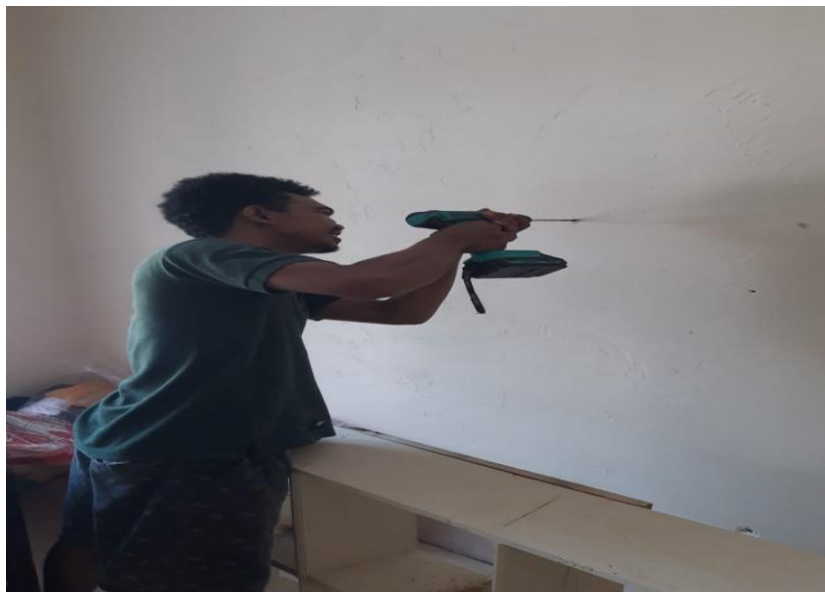
Gambar 1.8 Pemasangan Rak Buku
