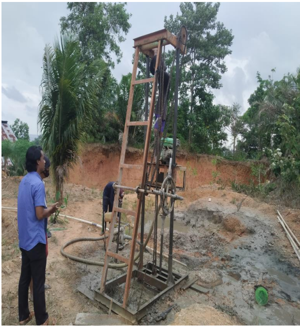
Proses pembuatan sumur bor
