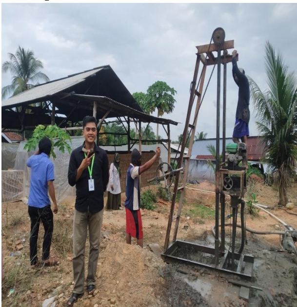
Proses pembuatan sumur bor
