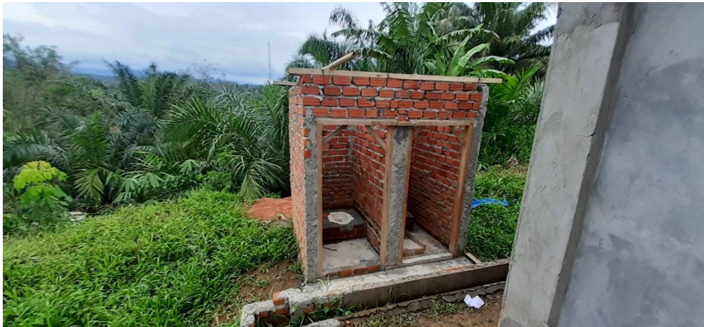
Fasilitas Sekolah dalam Tahap pembangunan di SMK Putra Nusantara 4 Bengkulu Tengah
