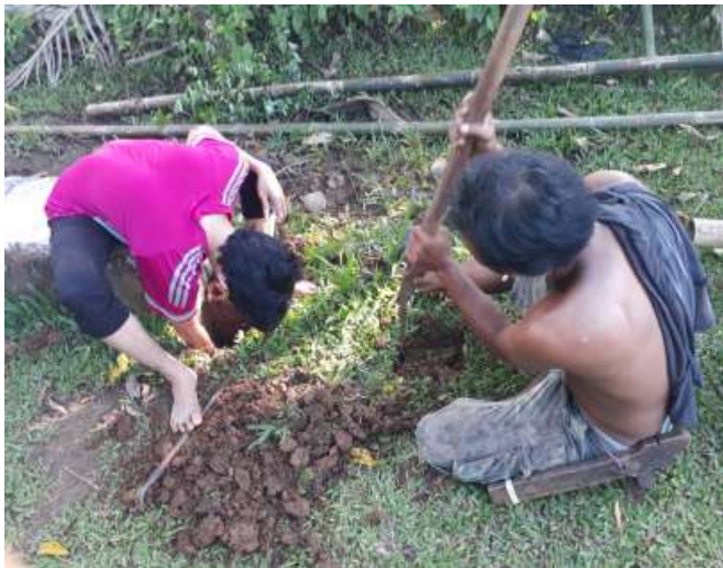
Proses penggalian tanah untuk mendirikan kerangka gapura
