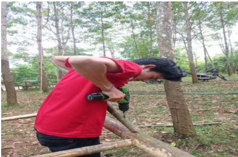
Pengeboran bambu bambu untuk gapura
