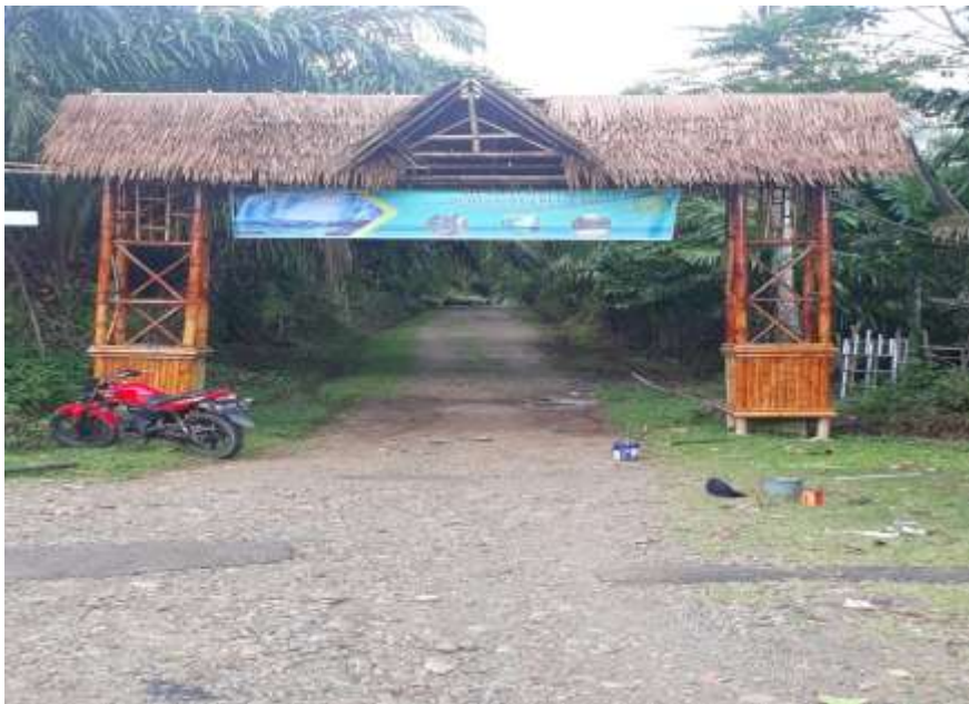
Gambar setelah selesai pemasangan atap, pengecatan dan pemasangan spanduk
