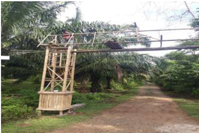
Proses pemasangan kerangka atas gapura
