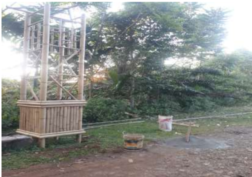
Gambar setelah berdiri nya kerangka gapura
