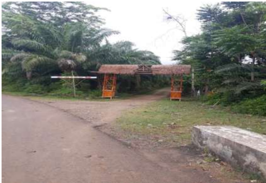
Gambar setelah terpasang nya atap sekitar 70% selesai
