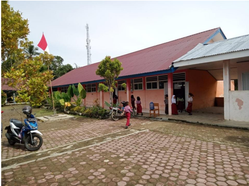
Lapangan dan Gedung Kelas SDN 21 Lebong
