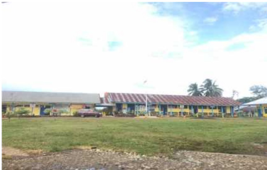
Kondisi Lapangan SDN 68 Bengkulu Tengah
