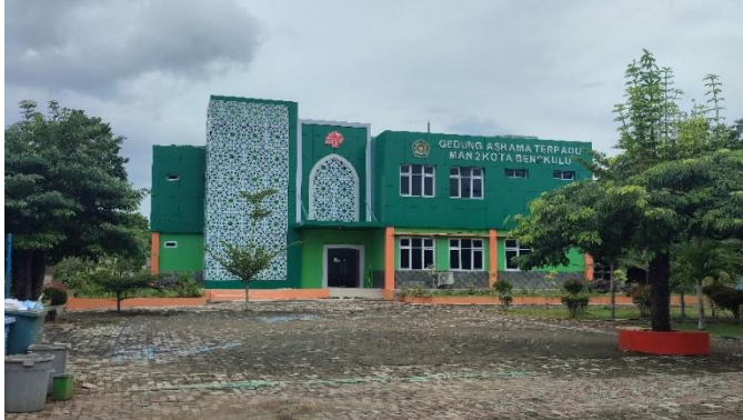
Kondisi Bangunan Asrama
