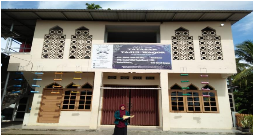
Gedung TPQ Tajul Waqor Kota Bengkulu
