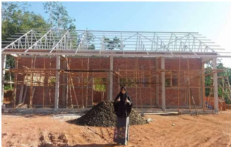
Gambar 4.3 Pondasi Gedung Sekolah
