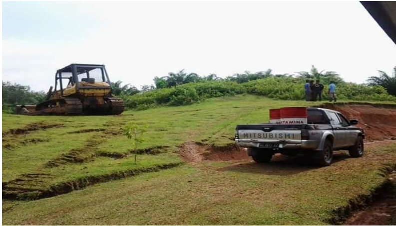
Gambar 4.1 Proses perataan Tanah
